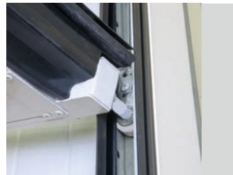
Dispositivo paracadute inserito nelle guide. Agisce in caso di rottura delle funi bloccando la caduta dell'anta mobile.
