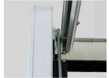
Particolare degli spazi di sicurezza ottenuti tramite la predisposizione HF.
