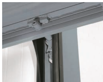
Dispositivo paracadute inserito nelle guide. Agisce in caso di rottura delle funi bloccando la caduta dell'anta mobile.
